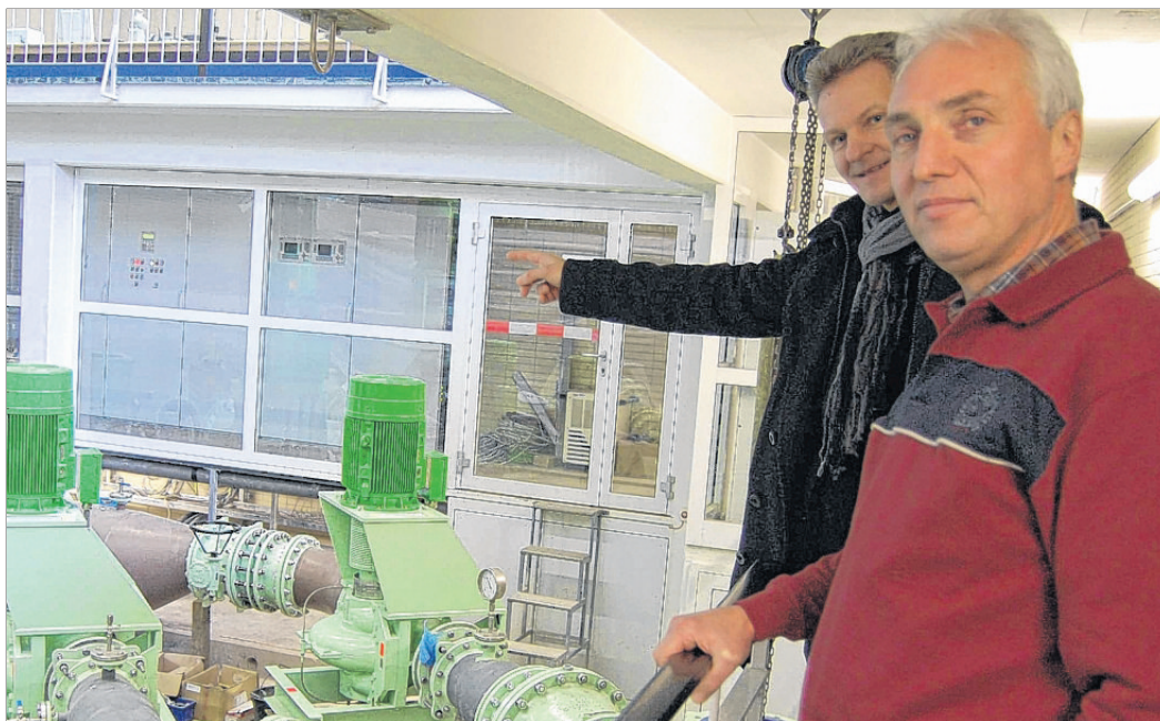
Andreas Körner (links) und Johann Bents zeigten gestern die neue Pumpenstation im Wasserwerk vor.
