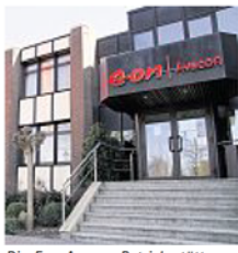
Die Eon-Avacon-Betriebsstätte am Sarstedter Bahnhof. Foto: Veit
