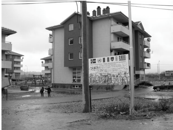
Rückkehrprojekt im ehemaligen Romaviertel, Januar 2009
