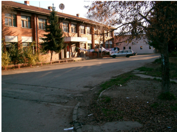
Wohngebäude im Camp Osterode
