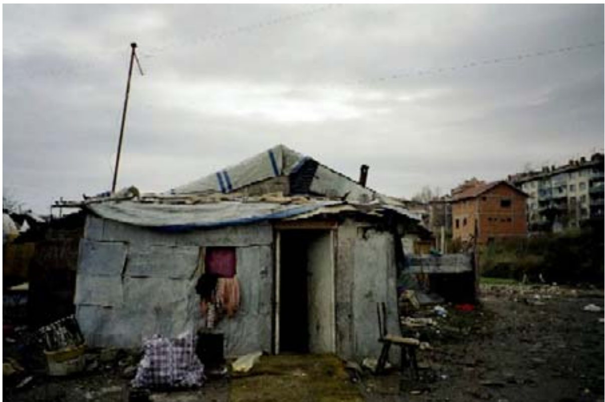
Elendsviertel im unteren Teil der Siedlung – nichtlegalisierte Behausungen
