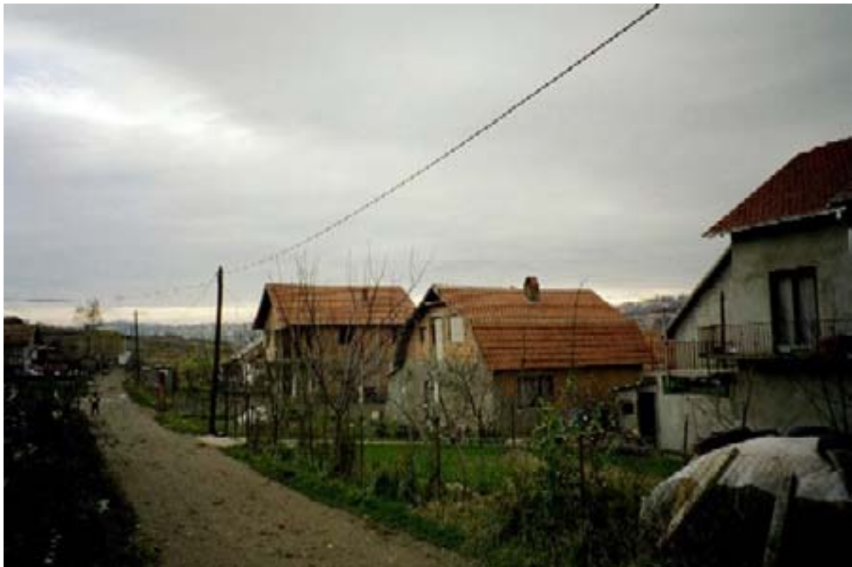
Legalisierter Teil der Siedlung Mali Leskovac – Häuser mit Wasser- und Stromanschluss
